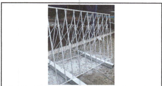
Foto 6: Sustitución Barandas de metal.
