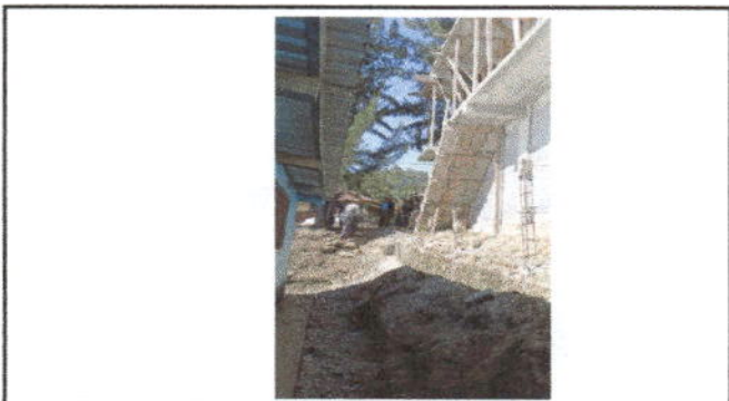
Foto 3: Reparacion de Malla galvanizada
