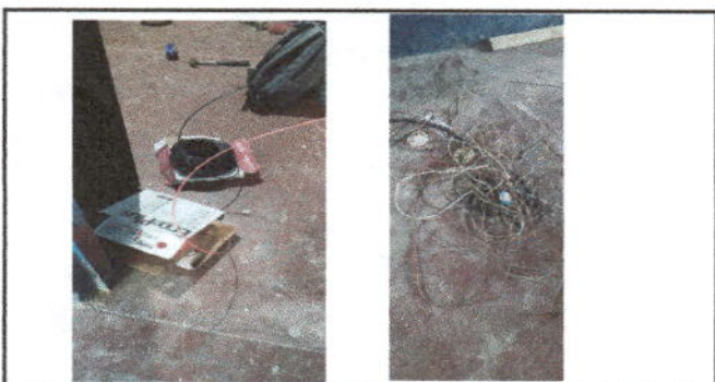
Foto 5: sustitucion de sistema electrico,
