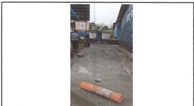
Foto 4: Reparacion de planchas de concreto de patio
